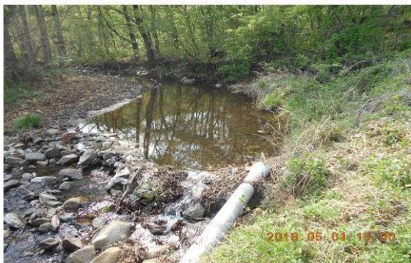
図5 取水堰と取水管（管の堰側で採水する）
