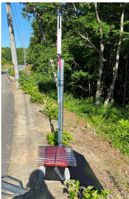
図3 キャンプ場につながる道路脇のAP (K1) と電源BOX
