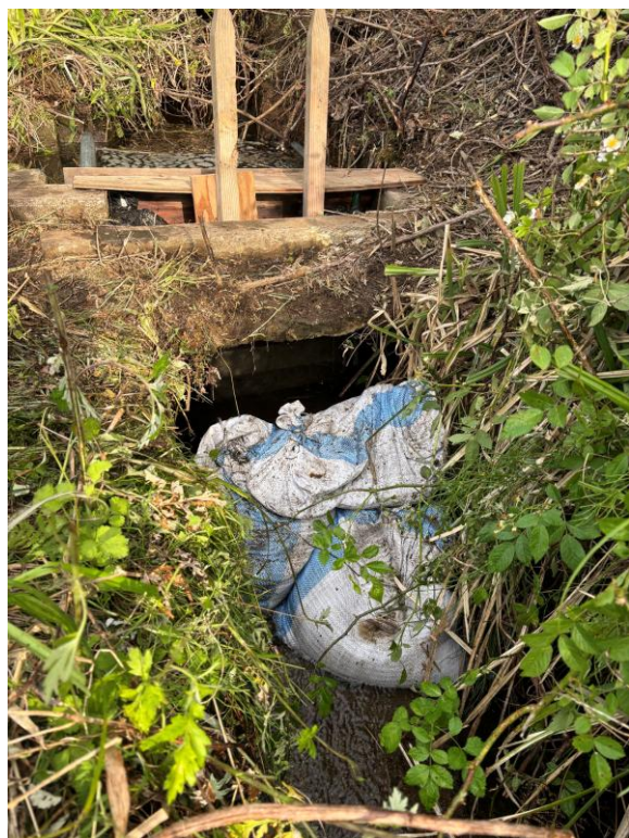
図1 止水板を設置して水位を確保しようとした最初の試み（2026年5月30日）
